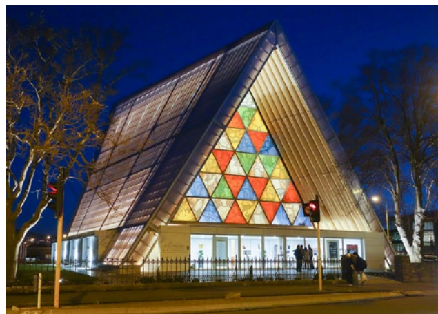
Die provisorische Kartonage-Kathedrale im neuseeländischen Christchurch ersetzt die 2011 durch ein Erdbeben irreparabel beschädigte ChristChurch Cathedral.
