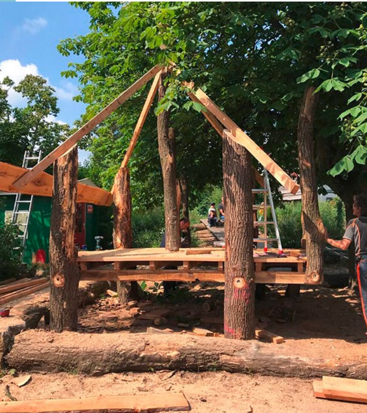
Ein Baumhaus entsteht.
